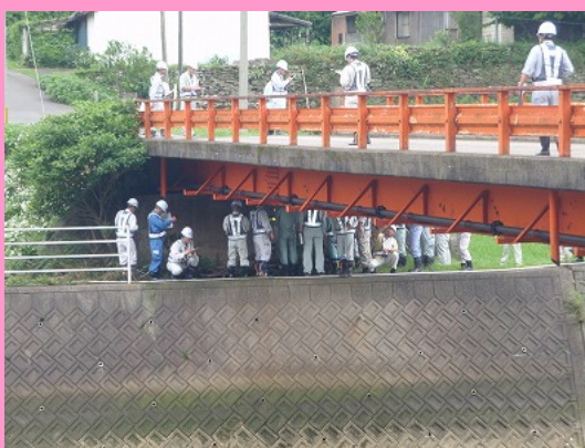
鋼構造物の点検風景
