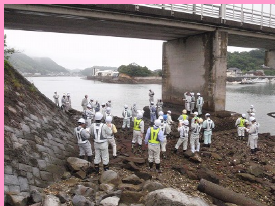
コンクリート構造物の点検風景
