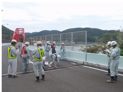
合同点検の様子
