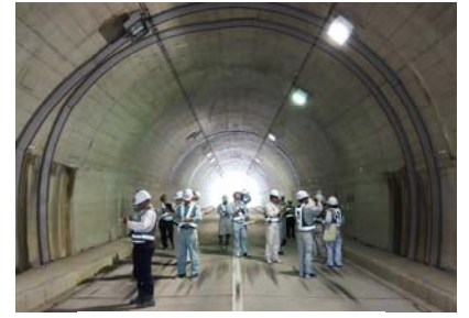
トンネル点検
