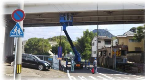
高所作業車を用いた桁下の近接目視点検
